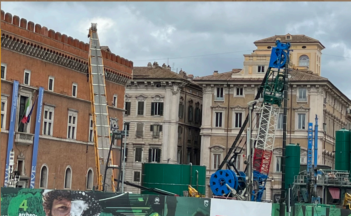
Trabajos para la construcción de línea del metro en el centro histórico de Roma, Italia. © RERM
