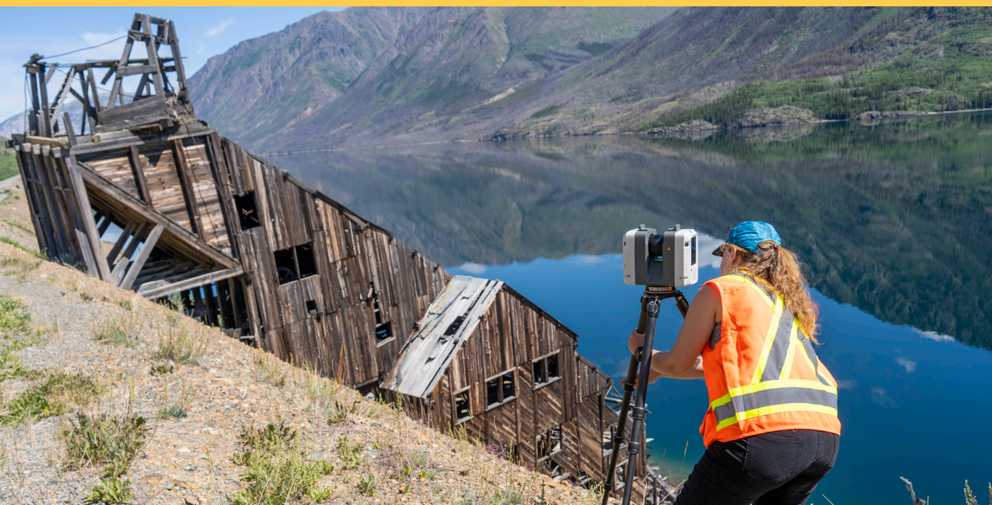
Escaneo 3D de la mina abandonada de Venus en el Yukon (Canadá) © Autor
